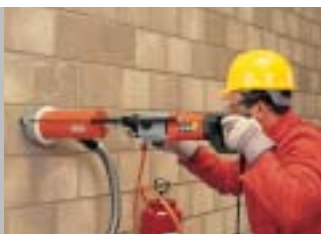
Použití sběrače vody pro ruční vrtání
