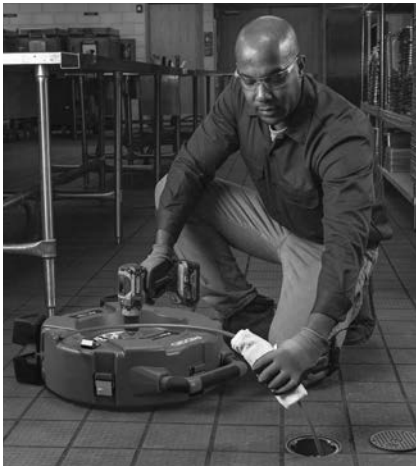
Obrázek 13 – Aplikace maziva na kabelové pouzdro
