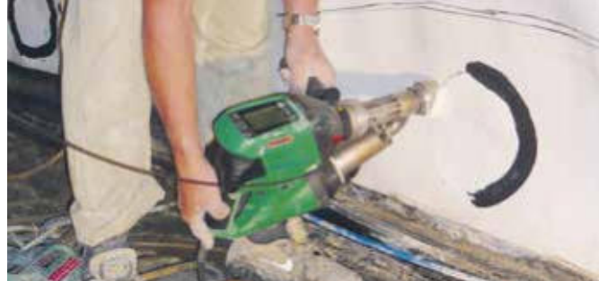
WELDPLAST S2 navařování záplaty v tunelu.
