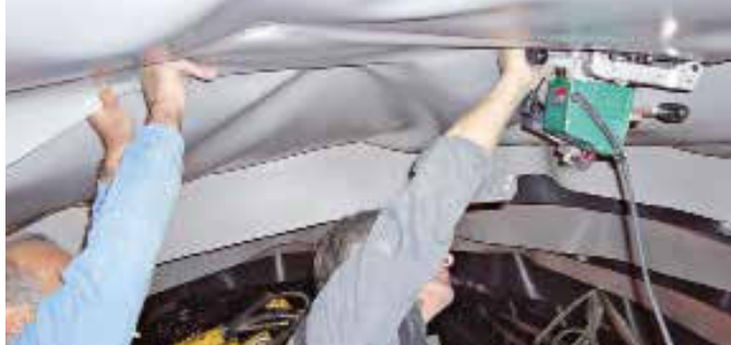
Svařování s přístrojem COMET v tunelu...
