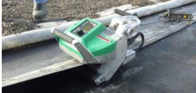
GEOSTAR zvládne bezproblémový svar v délce až 240 m.
