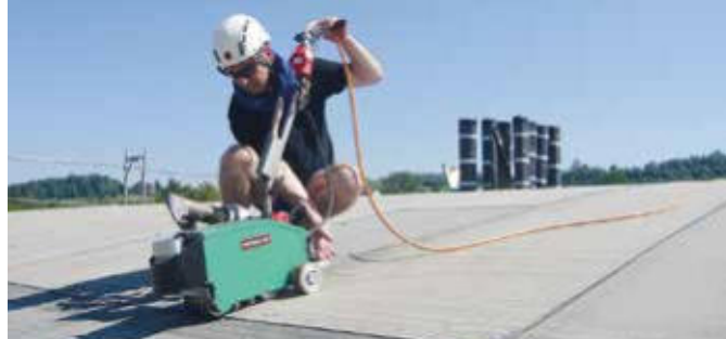
Bezplamenné svařování modifikovaného bitumenu - BITUMAT B2.
