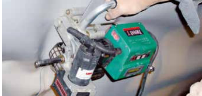
TWINNY T s praktickou příčnou rukojetí při svařování nad hlavou v tunelu.
