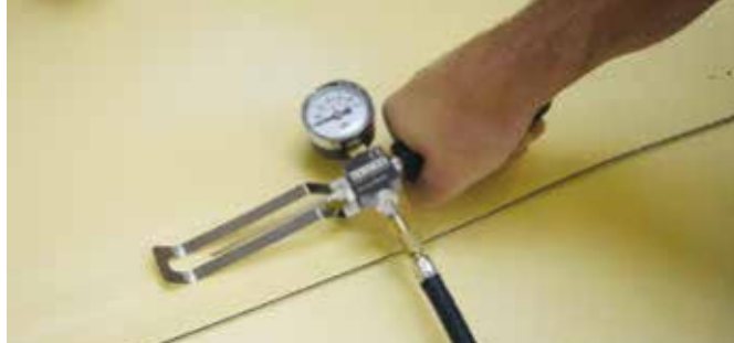
Testování těsnosti svarů s testovacím kanálkem
