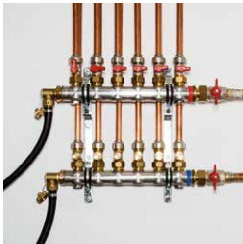
Proplachování radiátorů a plošných topných systémů
