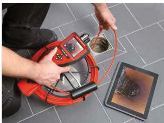
Inspekce podlahových odpadů
