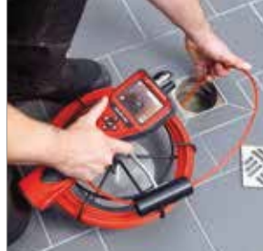
Inspekce podlahových odpadů
